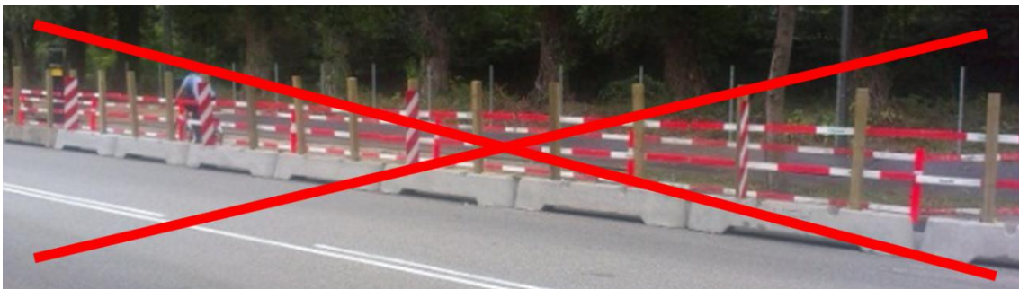
Figur 7.69 Eksempel på længdeafspærring med betonklodser mellem kørebane og cykelsti. Betonklodsen yder ikke beskyttelse af cyklisterne.
