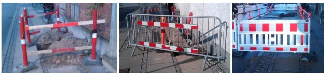
Figur 4.10 Eksempler på tværafspærring på fortov.
