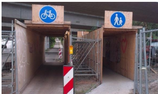
Figur 4.28 Eksempel på interimssti ved vejarbejde.
