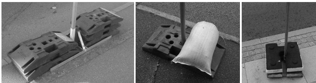
Figur 7.35. Eksempler på stabilisering af tavlestandere.
