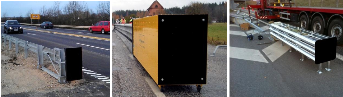
Figur 7.50 Eksempler på energiabsorberende trafikværnsender.
